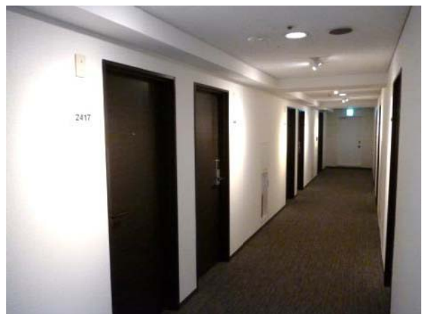
後楽賓館廊下（改修後）
